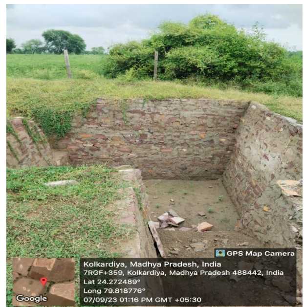
Siltation Pit -2 (L&W 5.5 and Depth 2.8)
